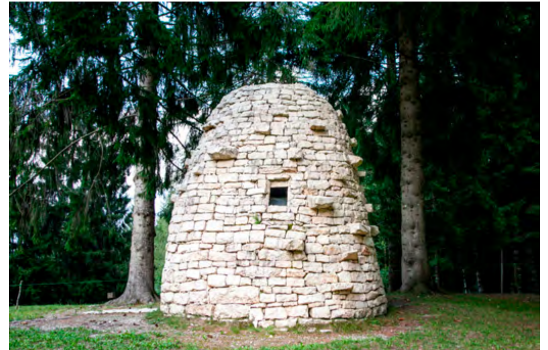
La stanza del cielo (Chris Drury, 2010) è una piccola struttura in pietra calcarea locale con una porticina d'ingresso e una piccola finestra. Rivolta a sud verso le cime delle Dolomiti, permette alla luce di entrarvi all'interno e trasformare lo spazio in una piccola camera oscura, proiettandone al suo interno l'immagine osservata all'esterno.
